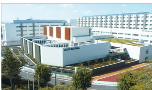
ROCK 重粒子線治療施設外観
